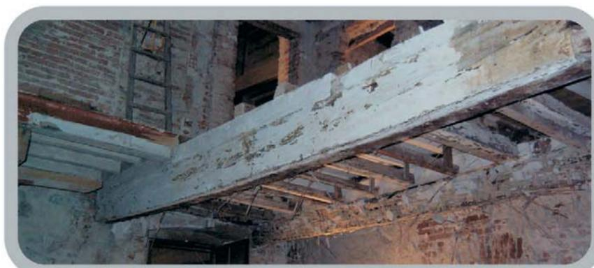
Rinforzo dei solai soprastanti la galleria. Rinforzo travi principali con sistema FLAP. Travi Secondarie con traliccio LPR®.
