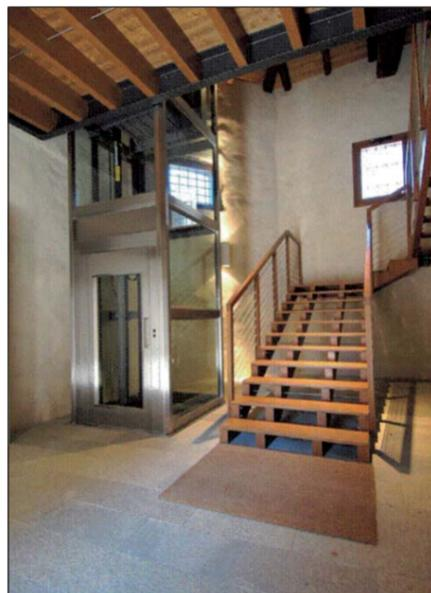
mate ed ha un unico accesso in cabina. La struttura portante è in acciaio inox spazzolato, come la cabina, le maniglie ed il corrimano.
