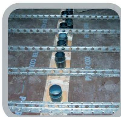
Applicazione del traliccio LPR® sui travetti e dei connettori Flap sulle travi secondarie.
