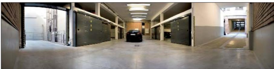
È arrivata in Italia una nuova tecnologia che permette di abbattere la profondità di scavo per la realizzazione dei parcheggi. Si tratta di Combilift 543 che è stata installata per la prima volta a Milano in un condominio di via Fatebenefratelli. L'intervento è stato realizzato in un palazzo degli anni Trenta in pieno centro cittadino, dove si è passati in poco tempo da 7 stretti garage a 35 posti auto adatti anche ai Suv.
