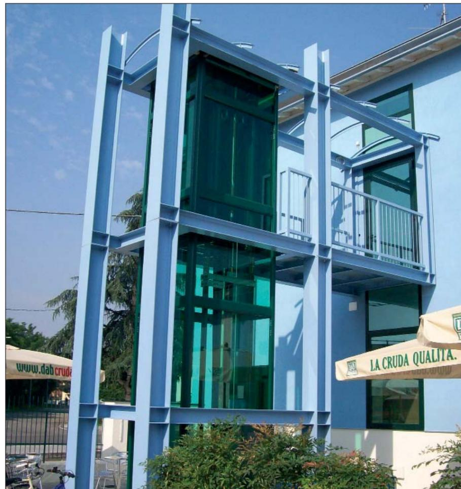
estetico: l'insieme dell'incasellatura è infatti completamente panoramico, costruito con un metallo in colore verde Ral 6005, molto simile a quello dei serramenti dell'edificio. Anche tutta la struttura dell'elevatore è panoramica ed è stata realizzata con un materiale della stessa tonalità di colore. Una parete della cabina è stata costruita con un particolare tipo
