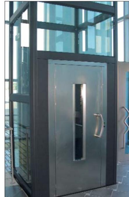
finiture (porte di piano, interno cabina...) in acciaio inox come quello con cui era stata già costruita la scala. L'incasellatura è composta da un materiale totalmente trasparente, si può quindi vedere l'ascensore che sale e scende, e sulle porte di piano ci sono delle aperture in vetro per alleggerire la struttura in acciaio. Si è riusciti quindi ad andare incontro alle necessità dei disabili, che devono avere la possibilità di muoversi all'interno dell'edificio.
